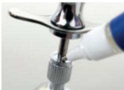
Verser 1 ou 2 gouttes d'huile dans le mécanisme de rotation.
